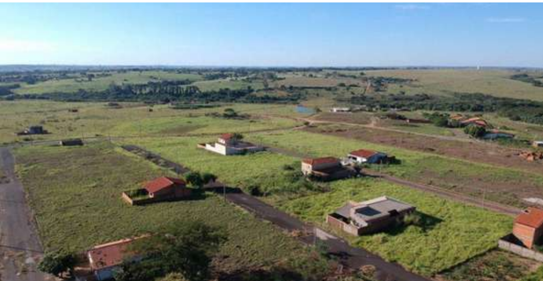
Obras do Auferville devem começar somente em 2027
